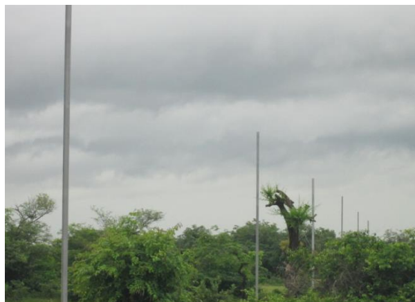
Einbetonierte Strommasten noch ohne Kabel
