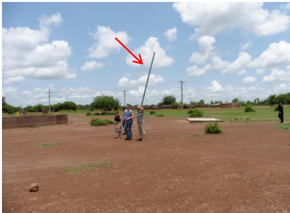
Erster provisorischer Strommast neben der an Straße entlangführenden Hauptleitung
