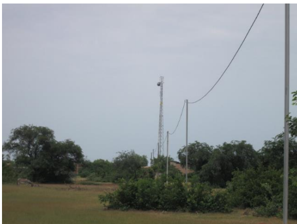
Erster provisorischer Strommast neben der an Straße entlangführenden Hauptleitung
